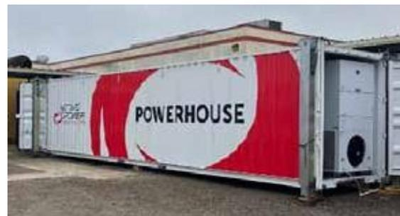
Figure 6. ルイジアナ州 Couchatta カジノ に設置された 1.2MW のレンタル POWERHOUSE
