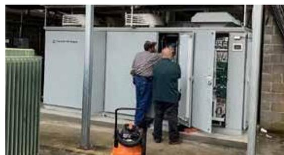
Figure 7. 交換された古いバッテリー式UPS
