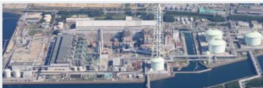
火力発電プラント
