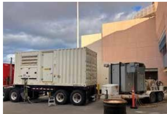
Figure 6. 試運転時に使用されたディーゼル 発電機と負荷装置
