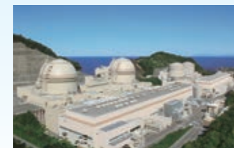
原子力発電設備代理店事業担当エリアの関西電力 大飯発電所
